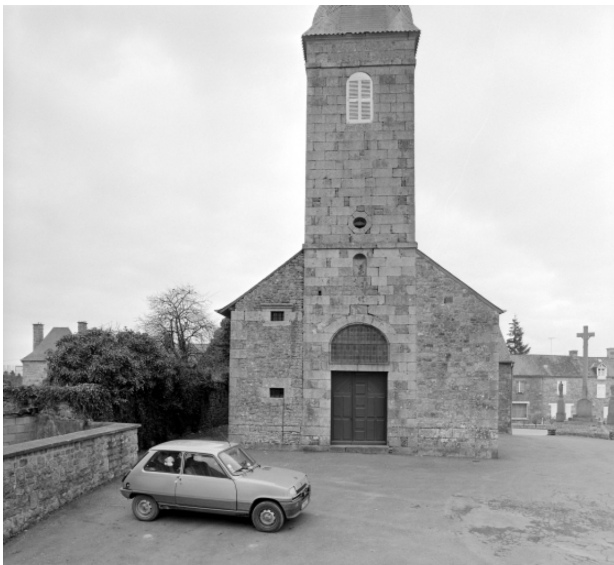
Elévation Ouest : vue générale
