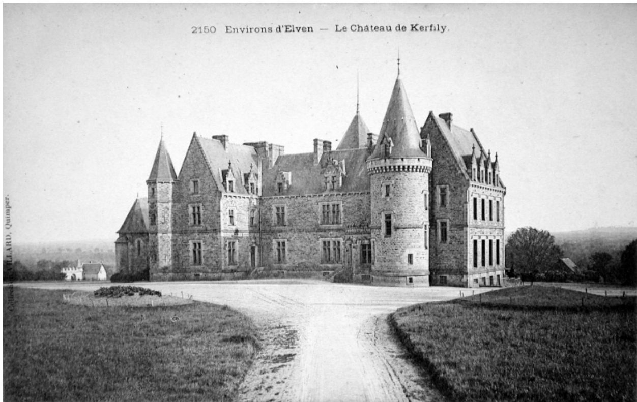
Vue générale des élévations sur cour
