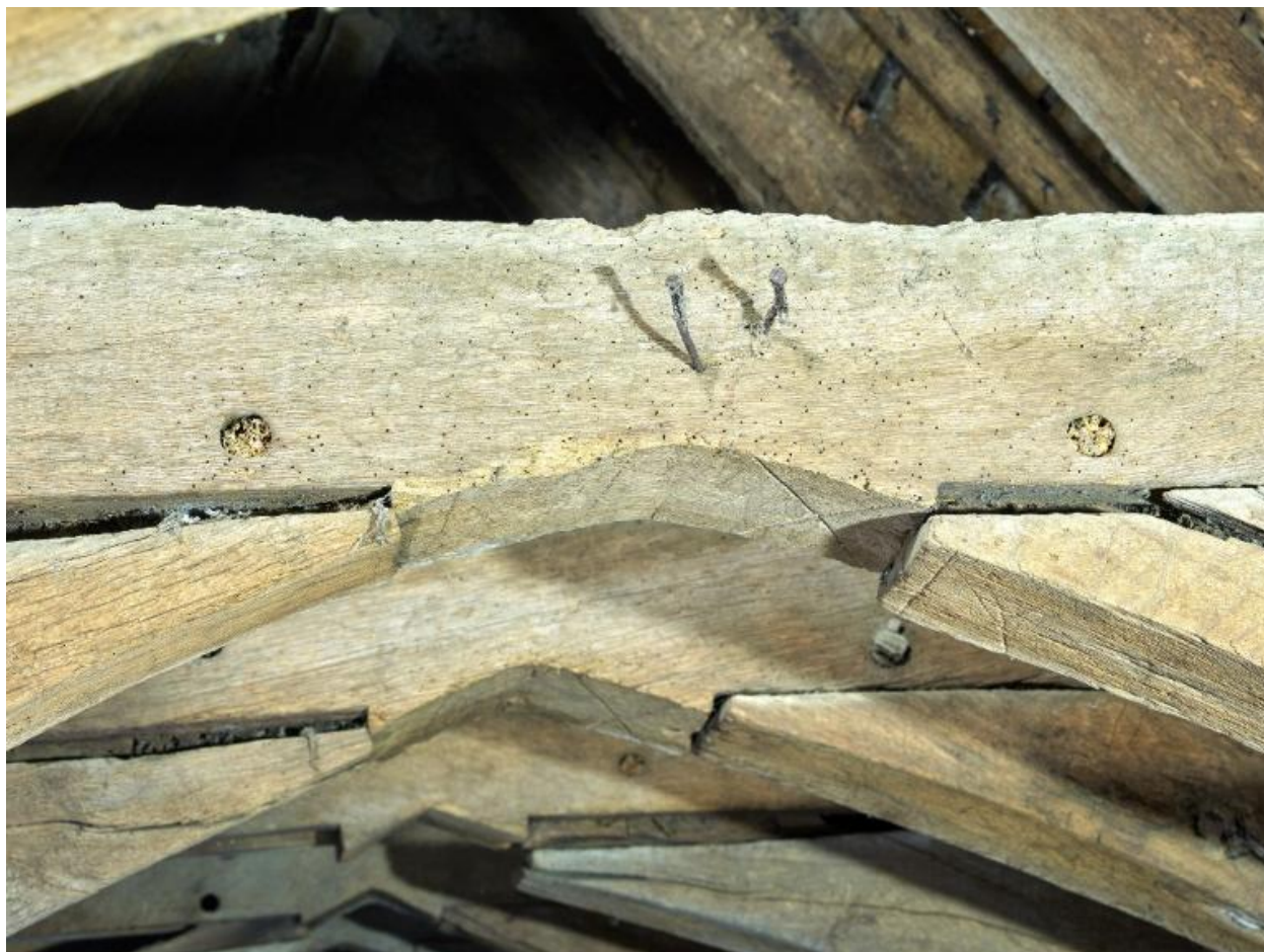
Assemblage en embrèvements des aisseliers.
