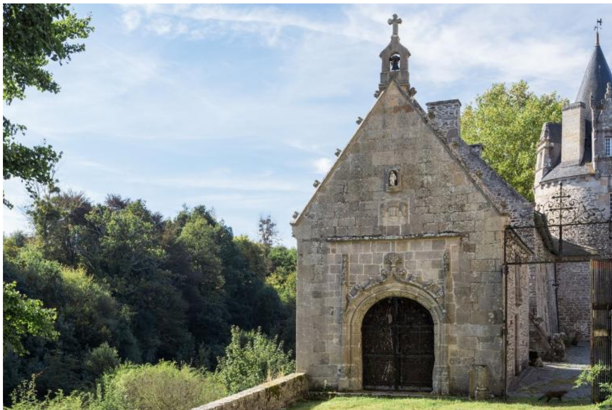
La chapelle, façade principale nord
