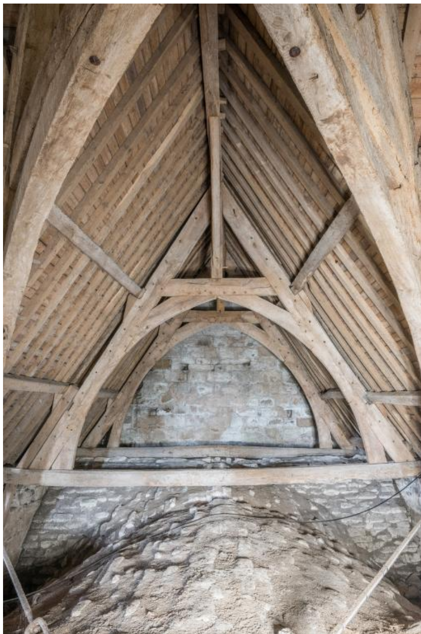
Vue de la charpente du bras sud du transept.
