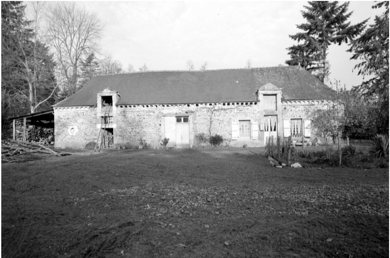
Dépendances, bâtiment nord : vue générale
