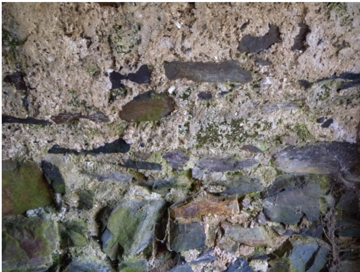
Vue de détail de la maçonnerie intérieure : moellons de schiste et liant en sable coquiller
