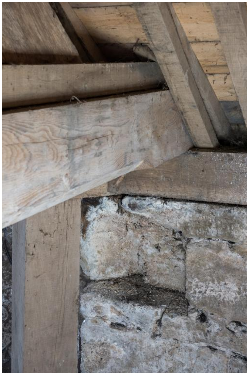
Vue de détail : vestige d'un empochement au sommet du mur nord de la travée droite du chœur.
