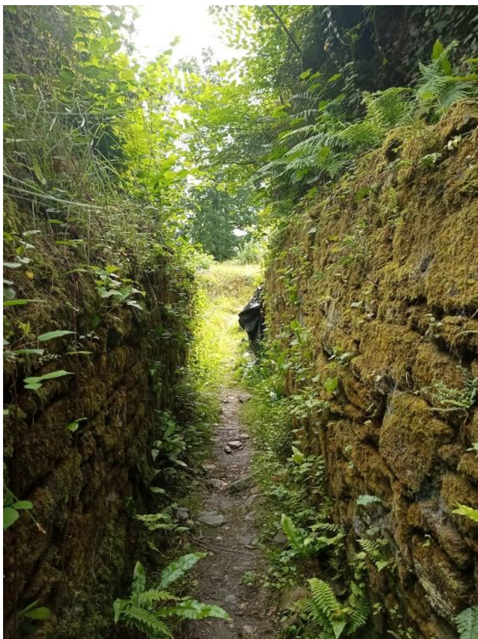
Vue de la porterie ouest : couloir
