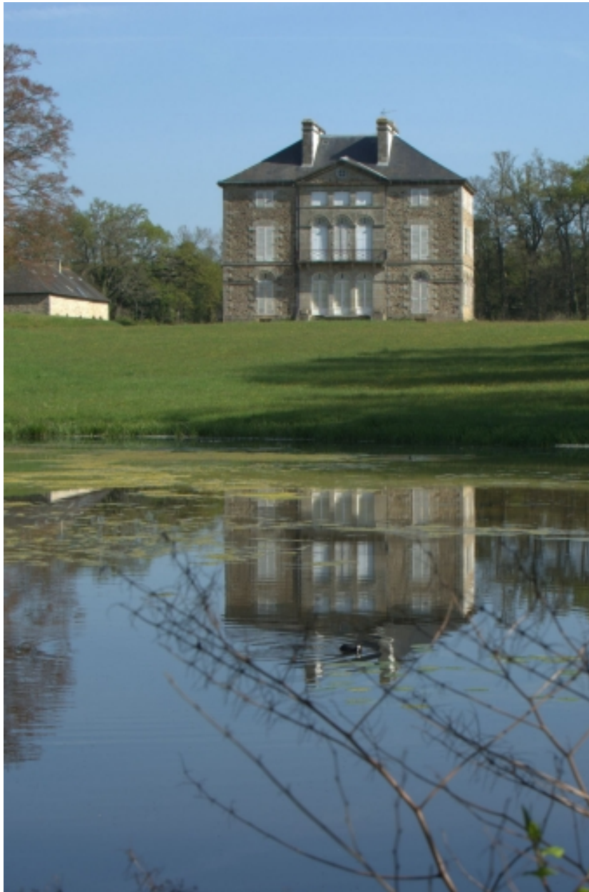
Château, étang et façade sud
