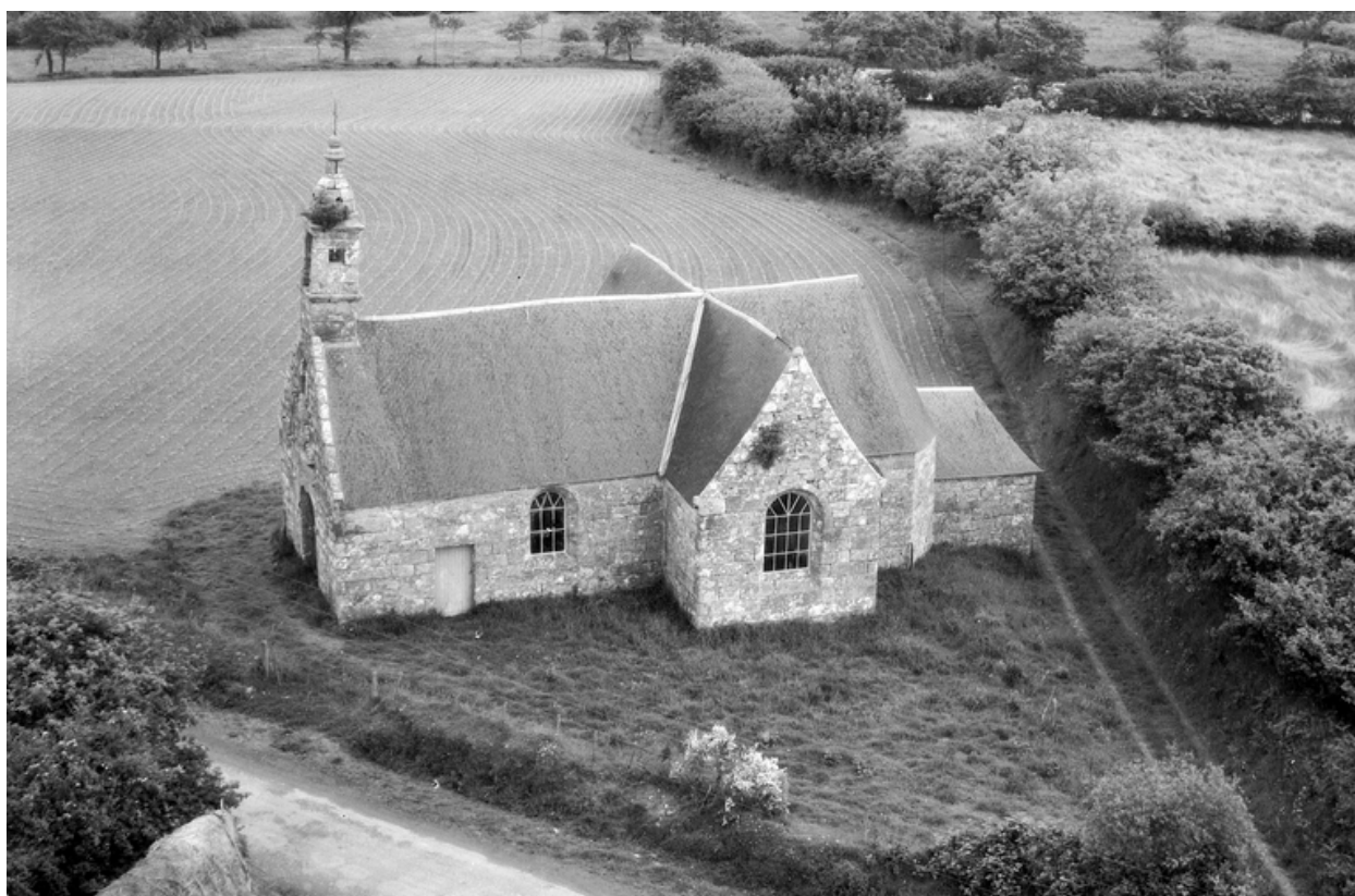
Vue de situation prise du sud
