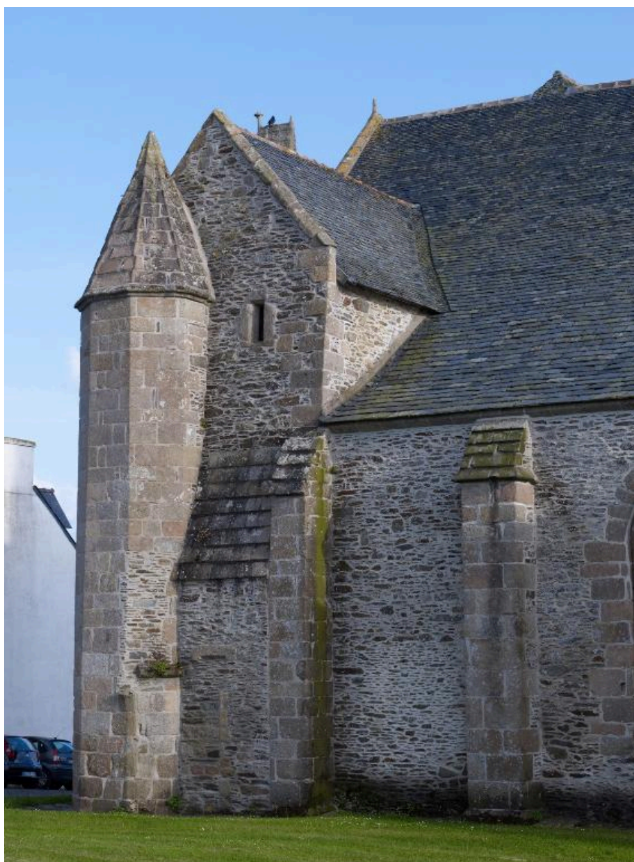
Construction d'angle nord-est. vue générale nord
