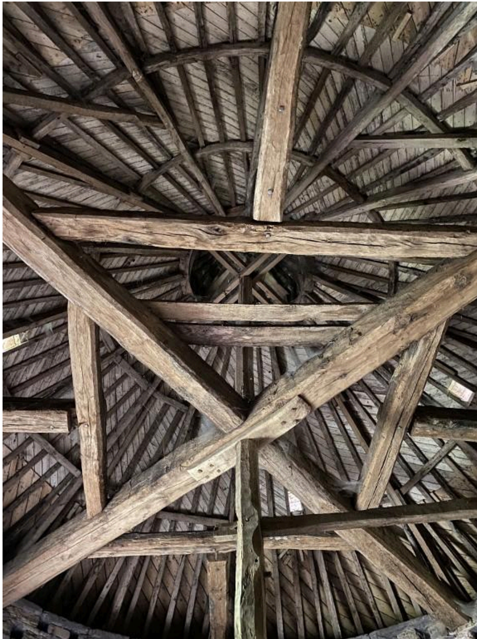
Charpente du colombier, détail
