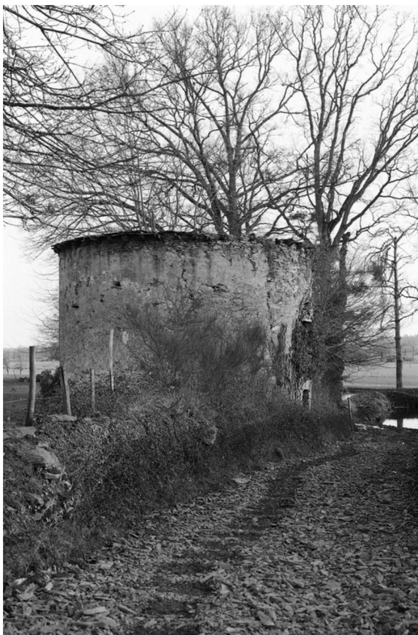
Pigeonnier, vue générale sud-est.
