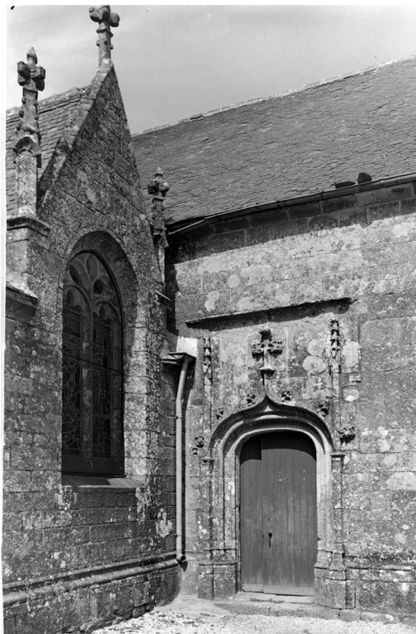
Croisillon sud, mur ouest : détail de la porte
