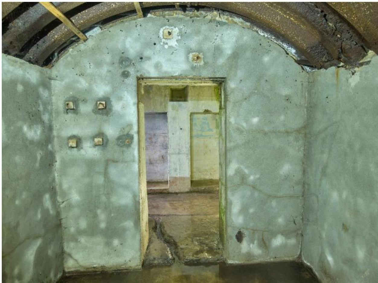
Vue de l'entrée de la salle de garde (couverte en tôle ondulée cintrée dite tôle métro). Le bunker a ultérieurement été transformé en logement (les murs ont été doublés en brique et enduit au ciment)
