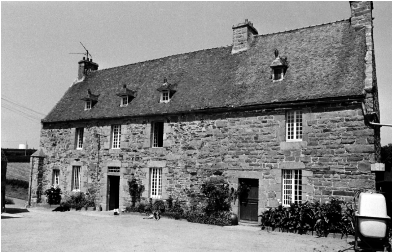
Corps de logis, élévation antérieure (cliché S. Laffiché, pré-inventaire, 1973)
