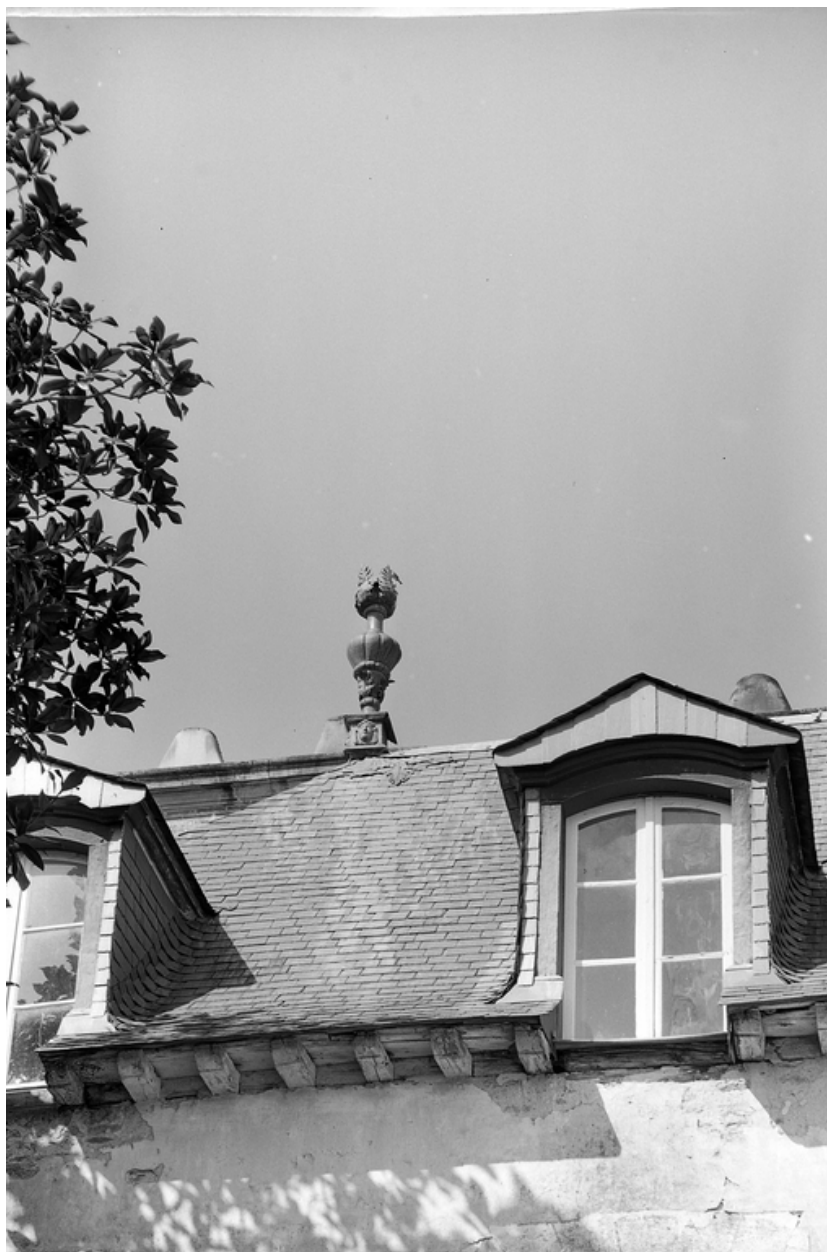
Vue de détail de l'épi de faîtage de l'avant corps sud.
