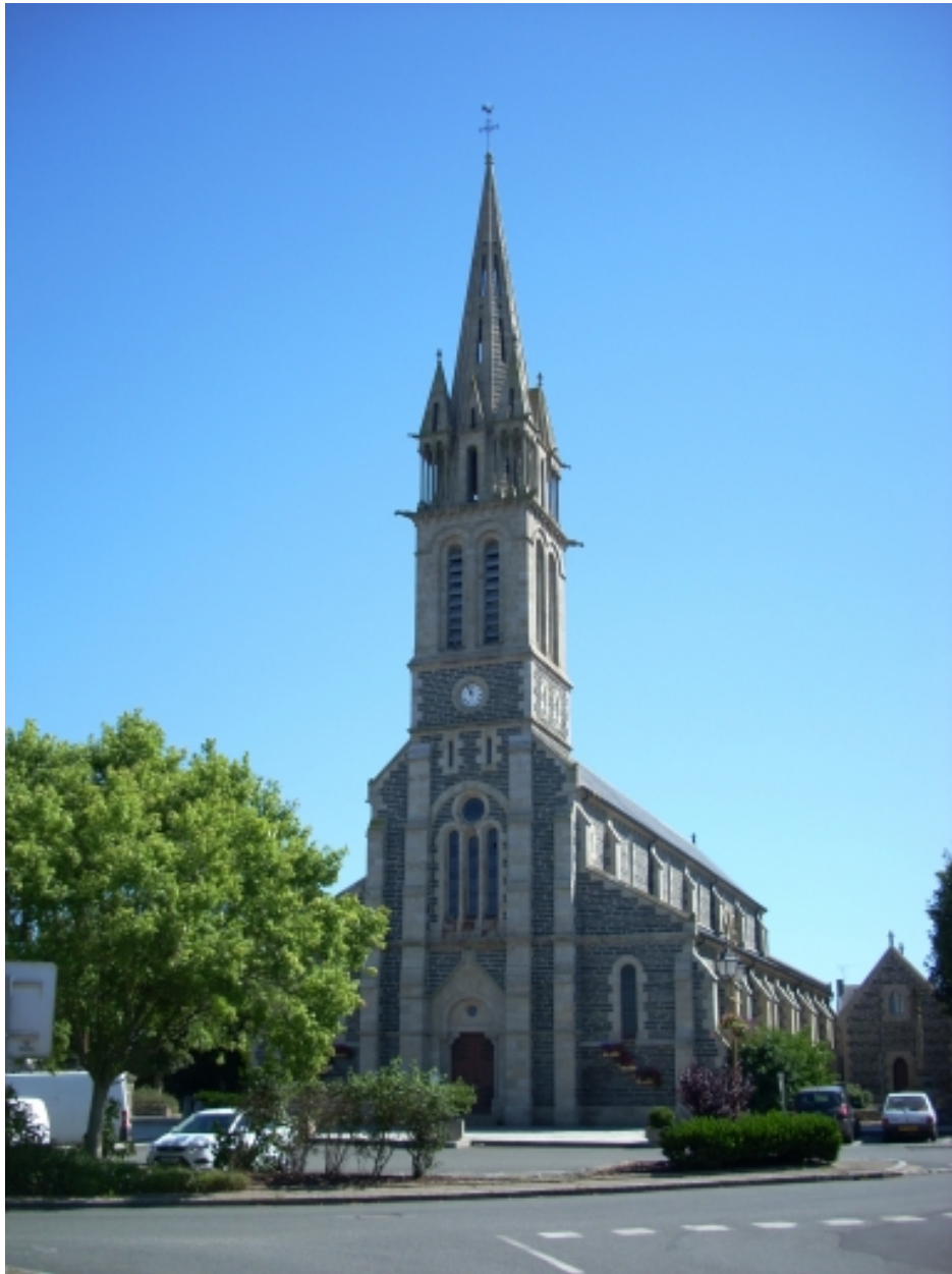
Taulé, église paroissiale Saint-Pierre : vue générale sud-ouest
