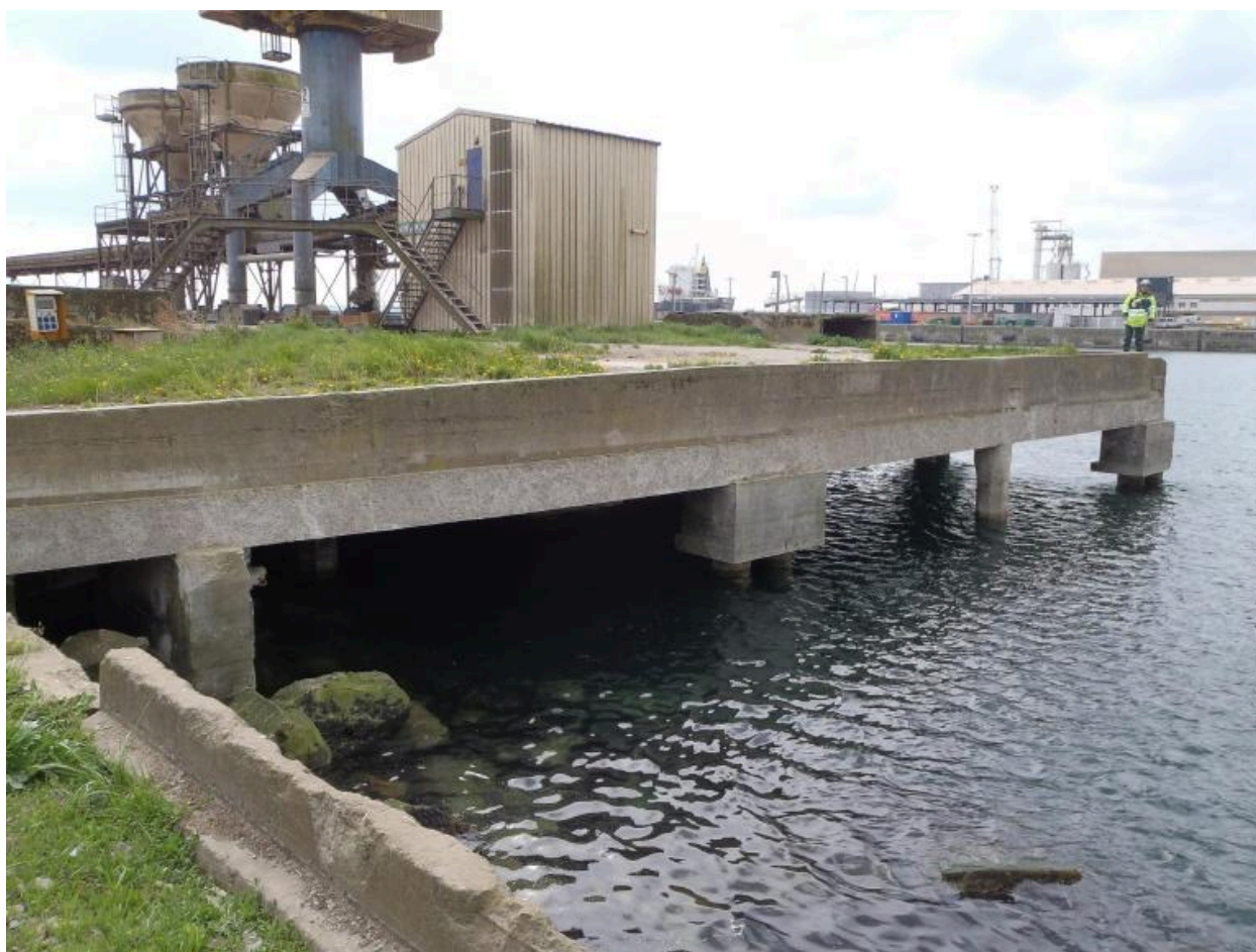
Quai Est minéralier
