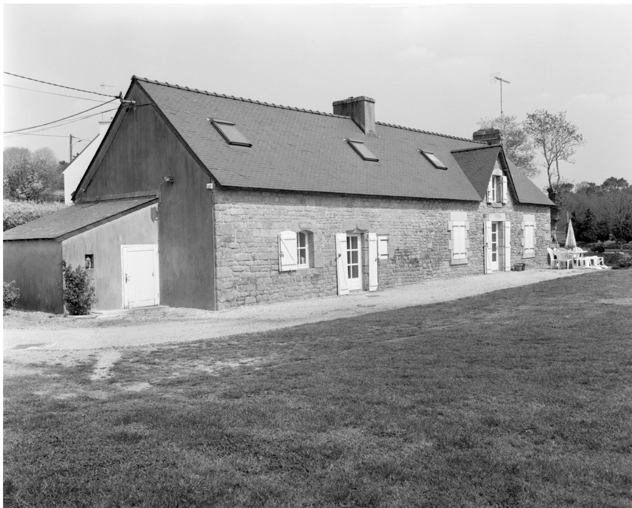
Loquion : ferme, élévation antérieure.
