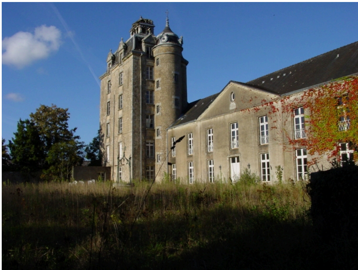
Donjon, vue générale sud-ouest.
