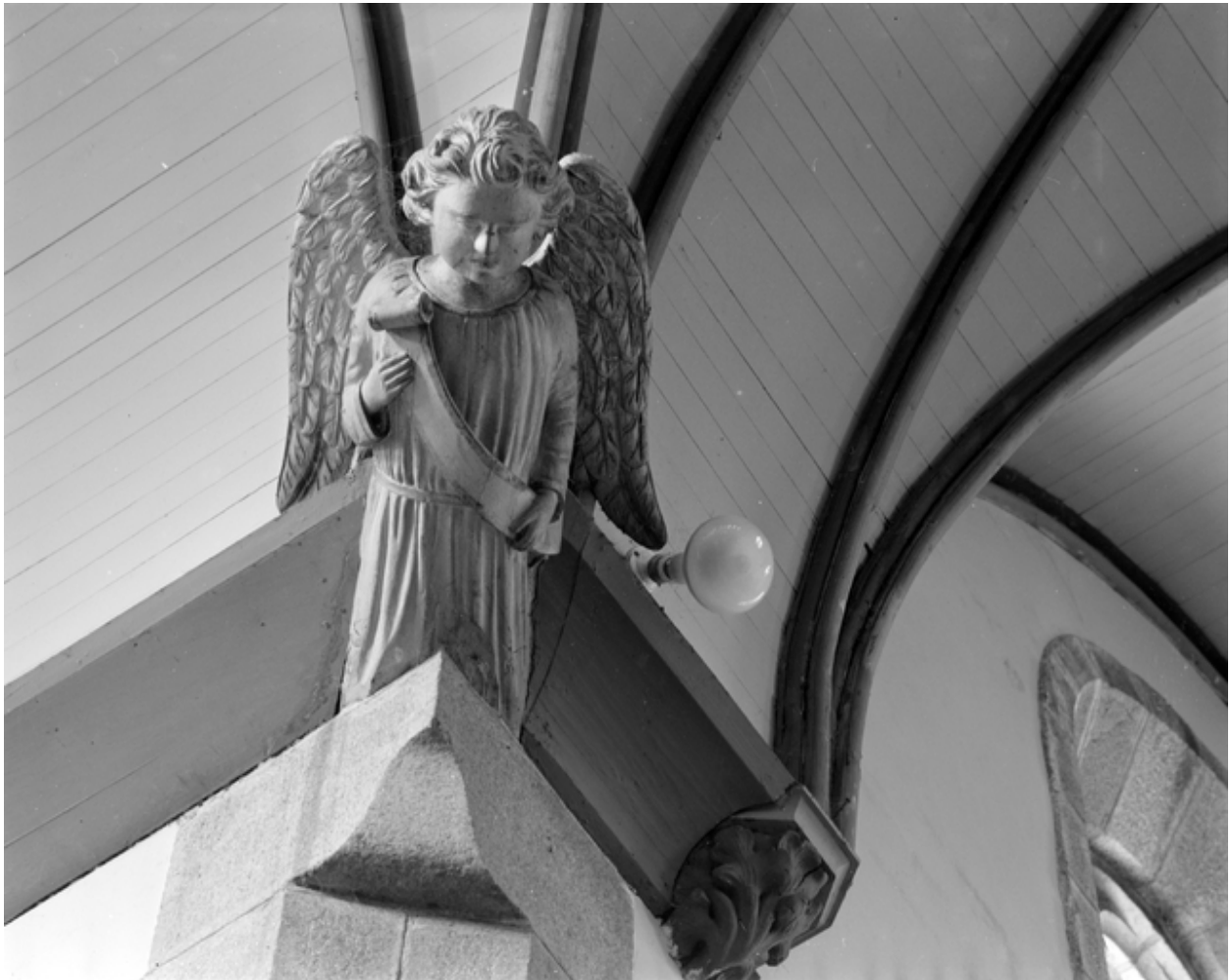
Châteaulin, église paroissiale Saint-Idunet : blochet, croisée, angle nord-ouest, état en 1972
