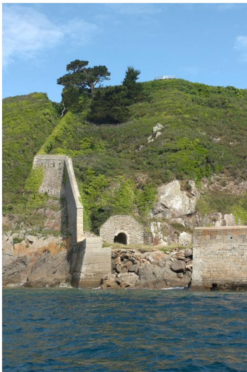
Plouzané : vue du fort du Mengant, mur d'enceinte dit branche tombante ouest percée de créneaux de mousqueterie et escalier parallèle. Abri de jour du projecteur
