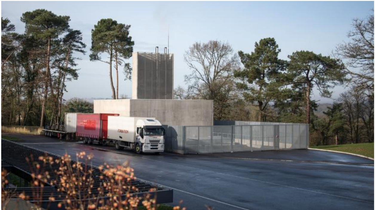
Nouvelle chaufferie bois située au nord des ateliers (David Cras, architecte, 2018).
