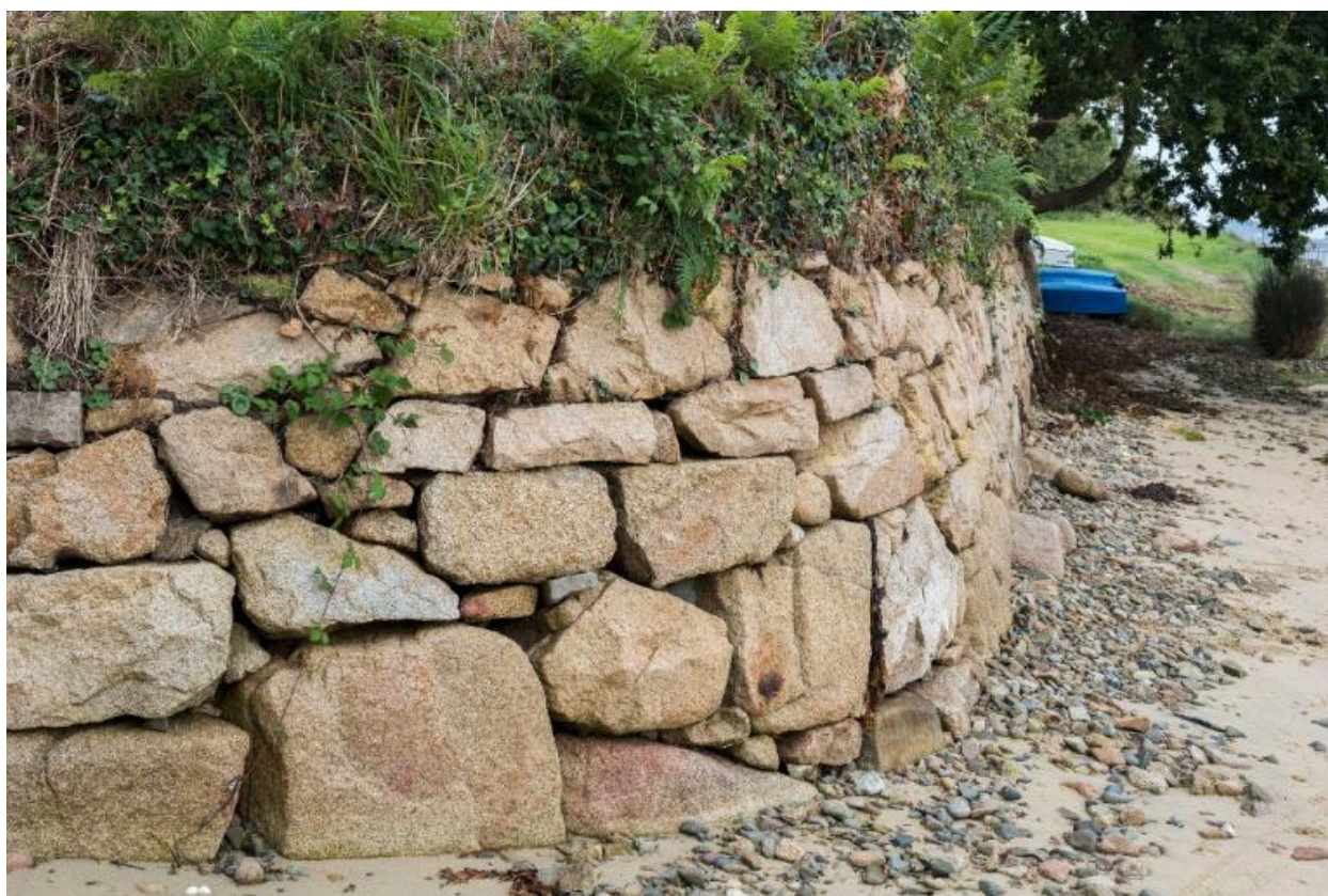
Vue d'un mur de soutènement faisant un angle arrondi au niveau du chemin menant à l'anse de Pelinec sur la rive ouest
