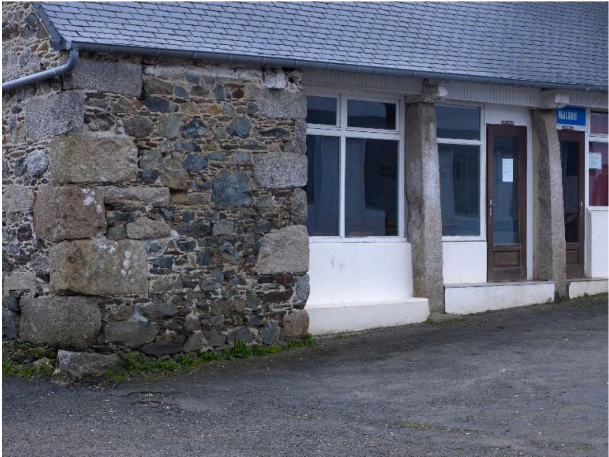
Remise agricole au nord-est du château. Détail
