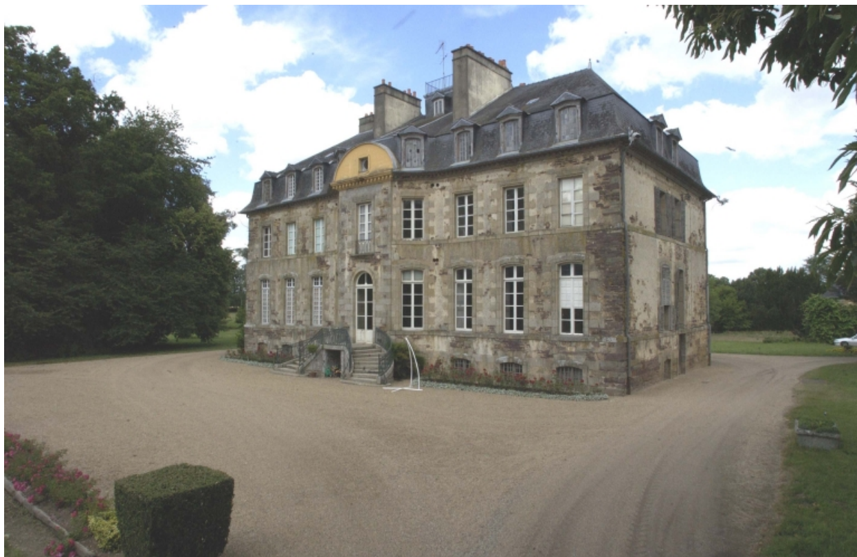
Château, vue générale prise de trois quart
