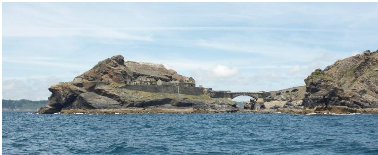
Roscanvel : vue de l'ensemble fortifié de l'îlot des Capucins depuis la mer, face sud
