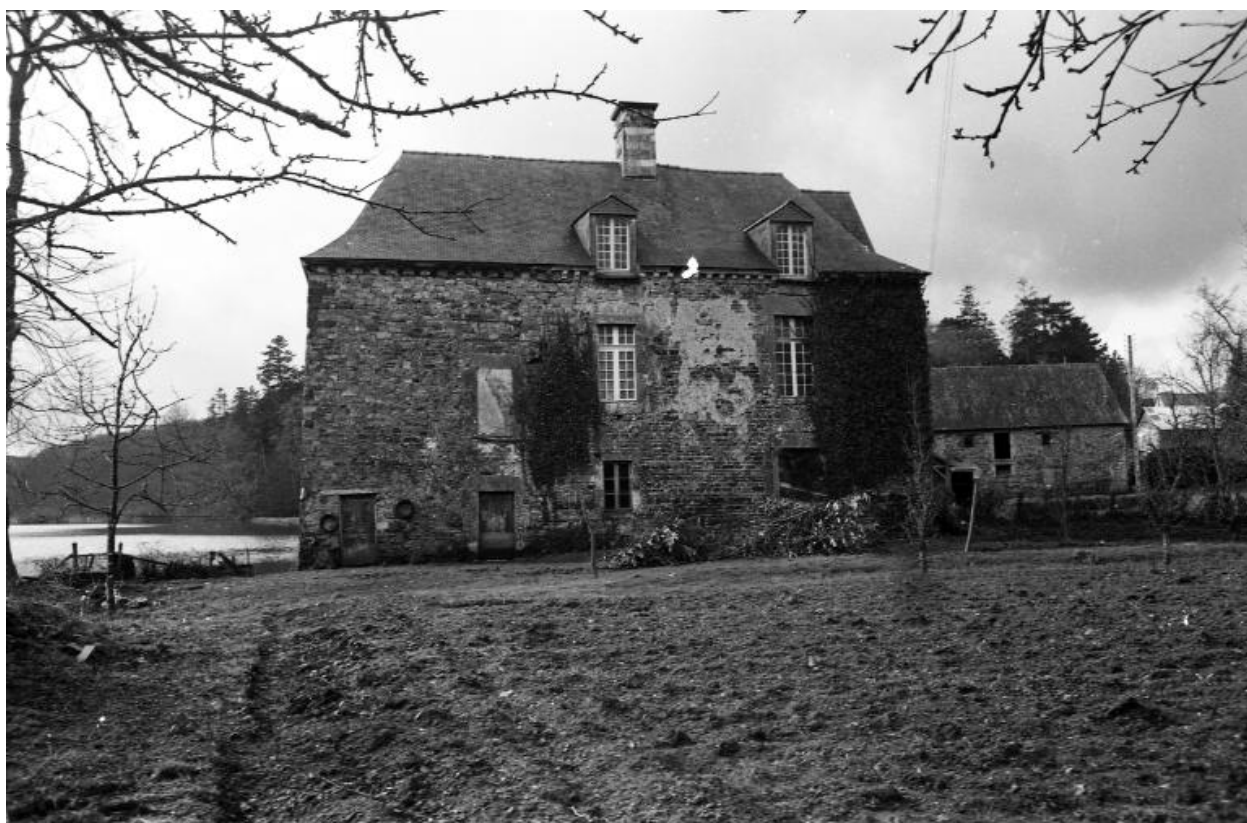
Face nord, vue générale.
