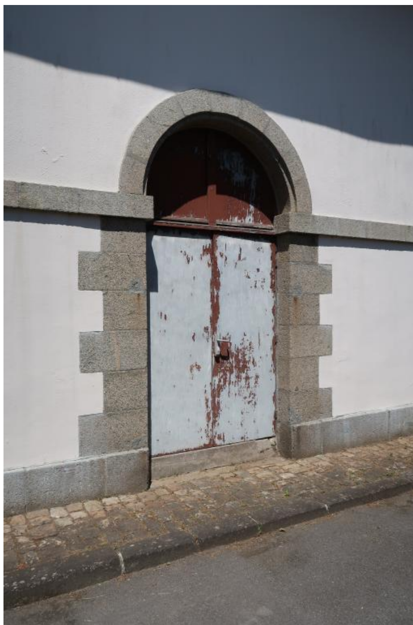
Vue de détail d'une baie (état en 2022)
