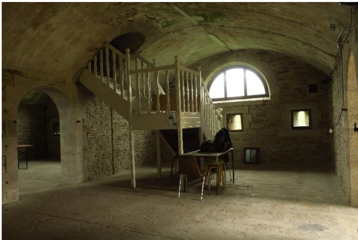
Groix, batterie du Gripp, corps de garde crénelé, première travée.
