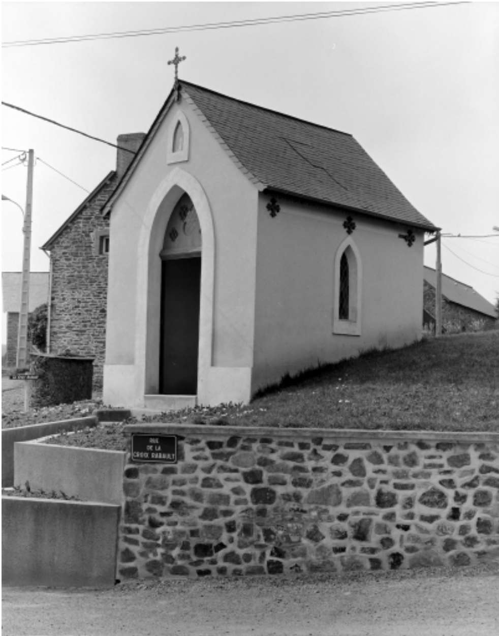
Elévation Nord-Est : vue générale
