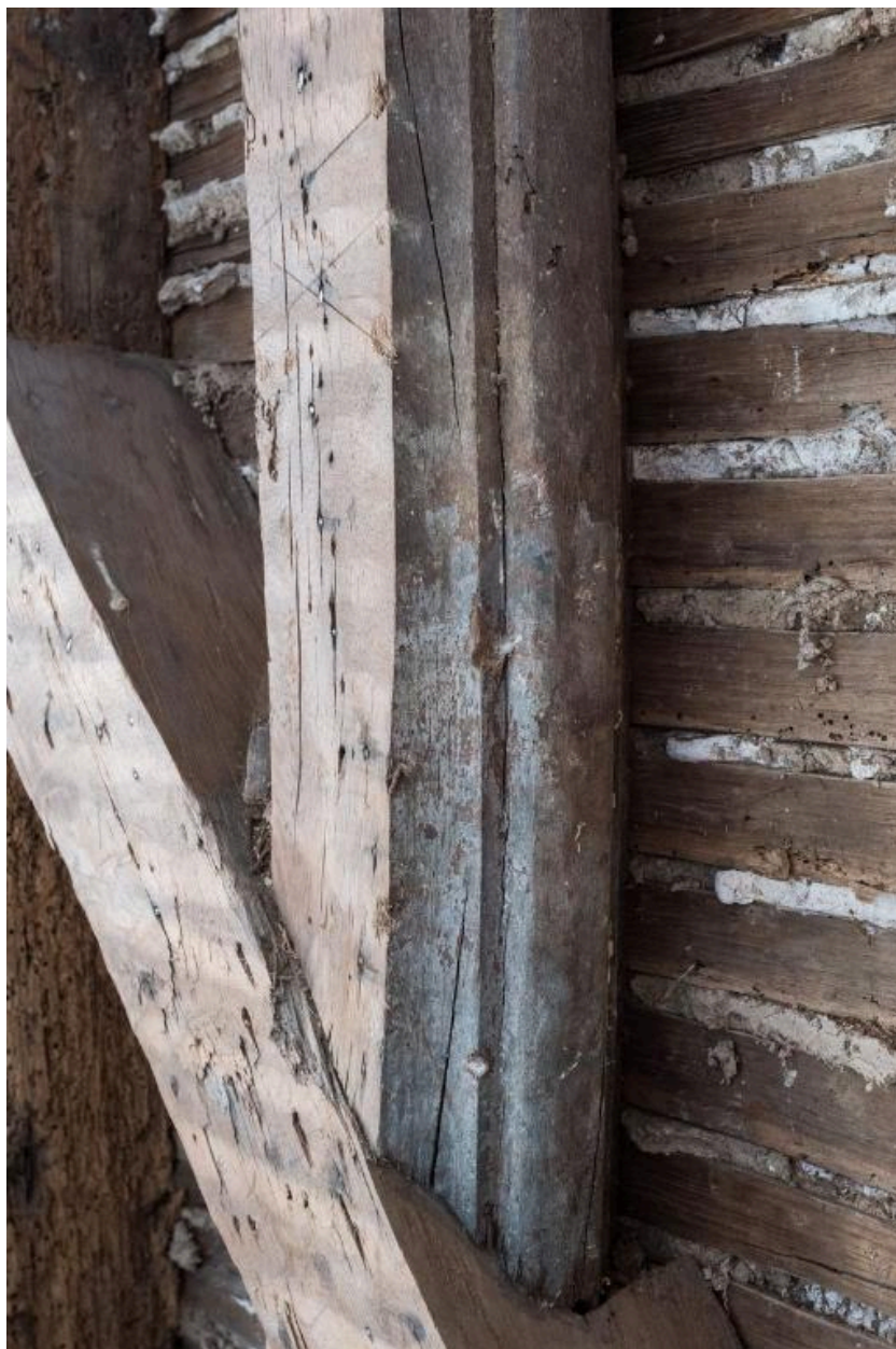
Premier étage, pièce de bois moulurée réemployée comme tournisse.
