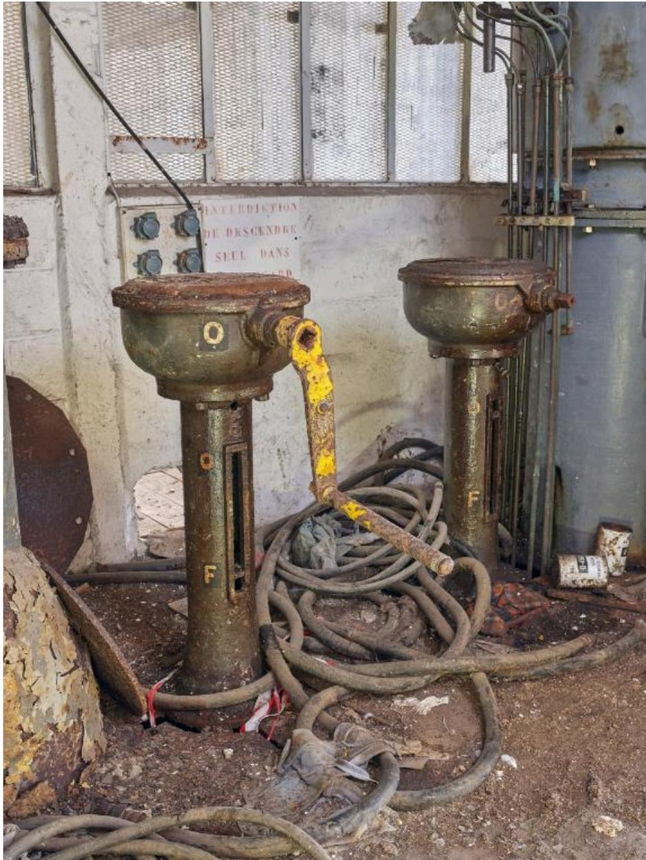
Vue du local des pompes sud situé entre les alvéoles A et B : commandes de pompe (dans cet espace, il faut imaginer la forte odeur de graisse mécanique). Elles fonctionnaient avec une manivelle. Sur le mur : consigne de sécurité concernant le puisard
