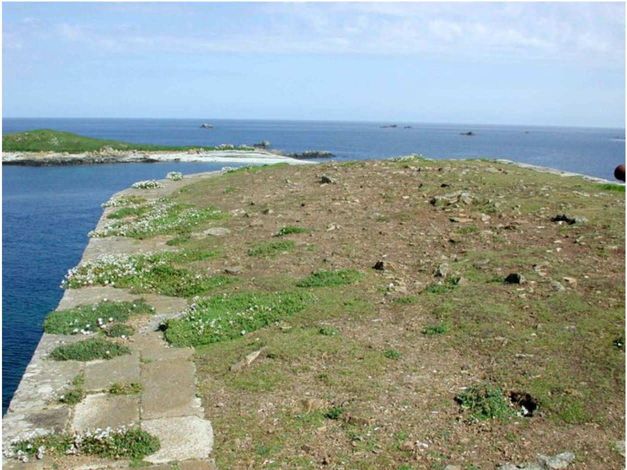
Vue du parapet de la batterie de la Théroute. En arrière plan : l'île plate
