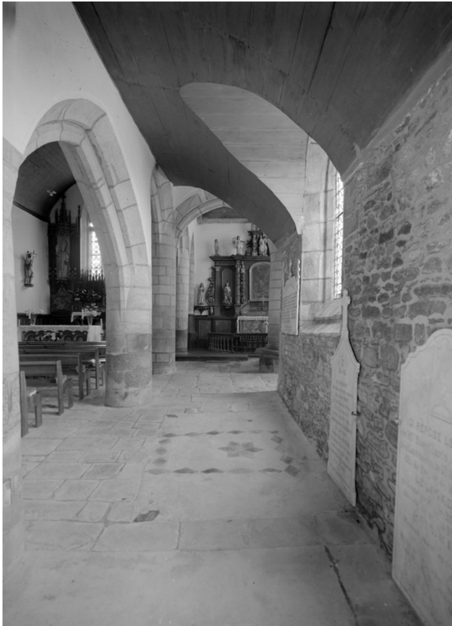
Bas-côté sud d'ouest en est
