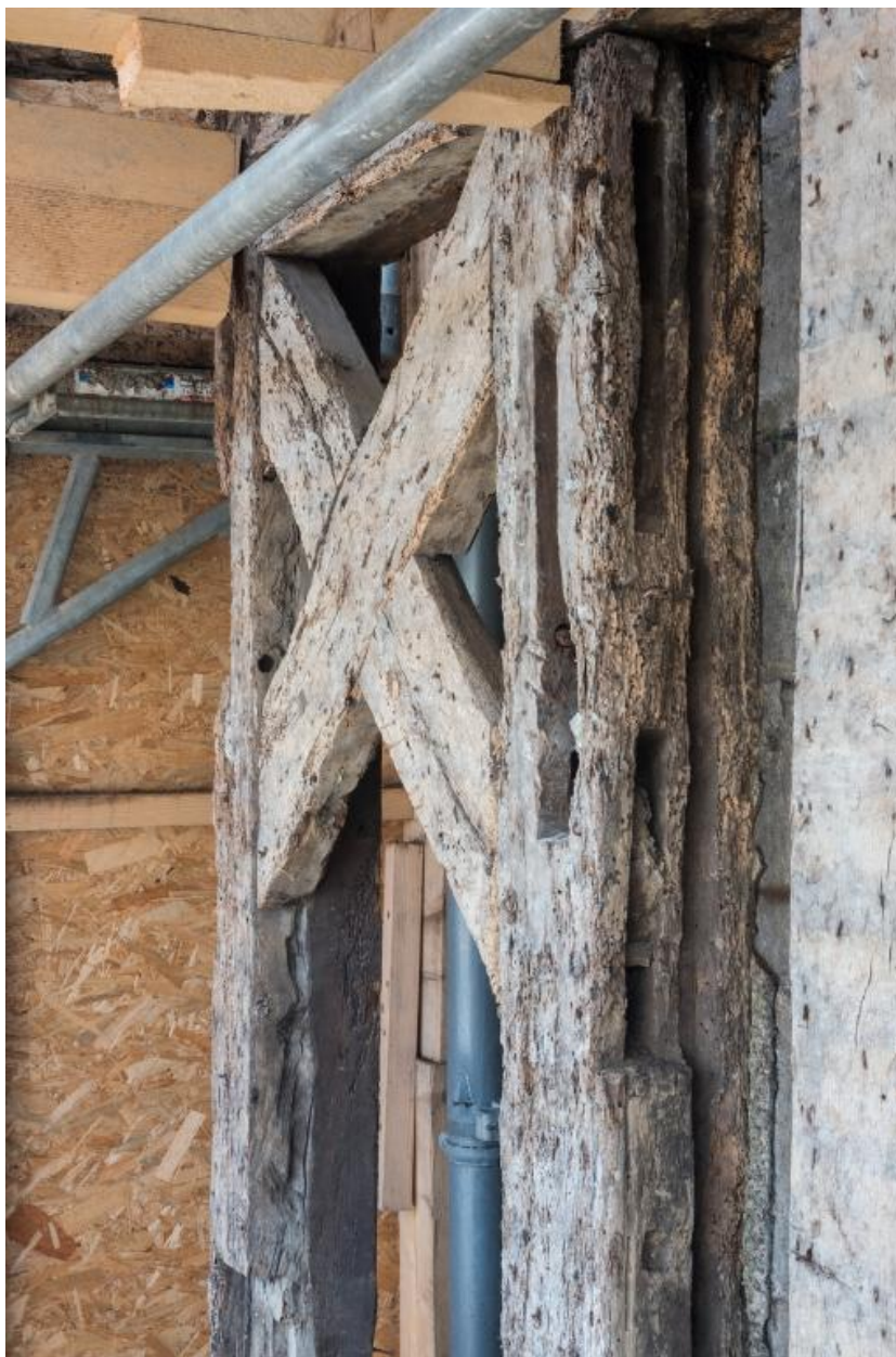
Croix de Saint-André et mortaises orphelines dans la façade du premier étage (restauration en 2021).
