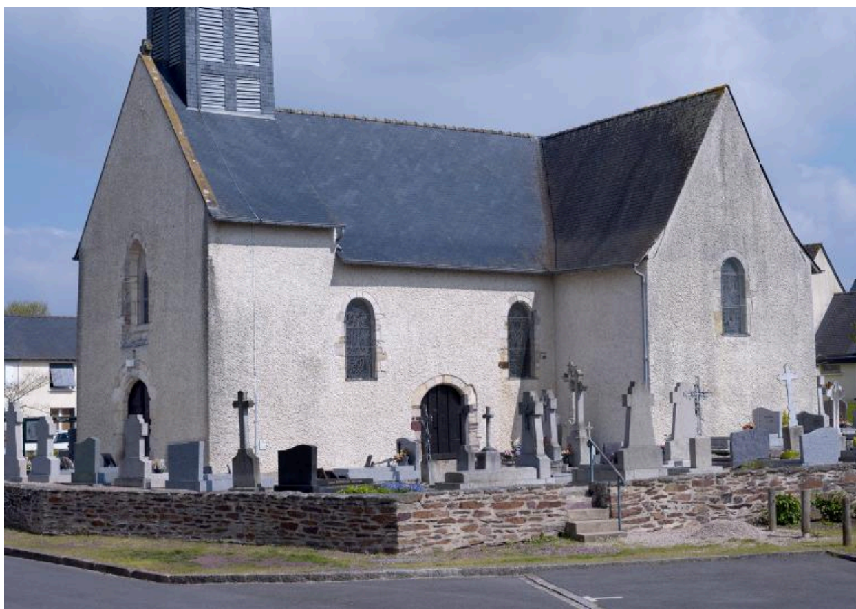
Eglise Saint-Melaine, façade nord
