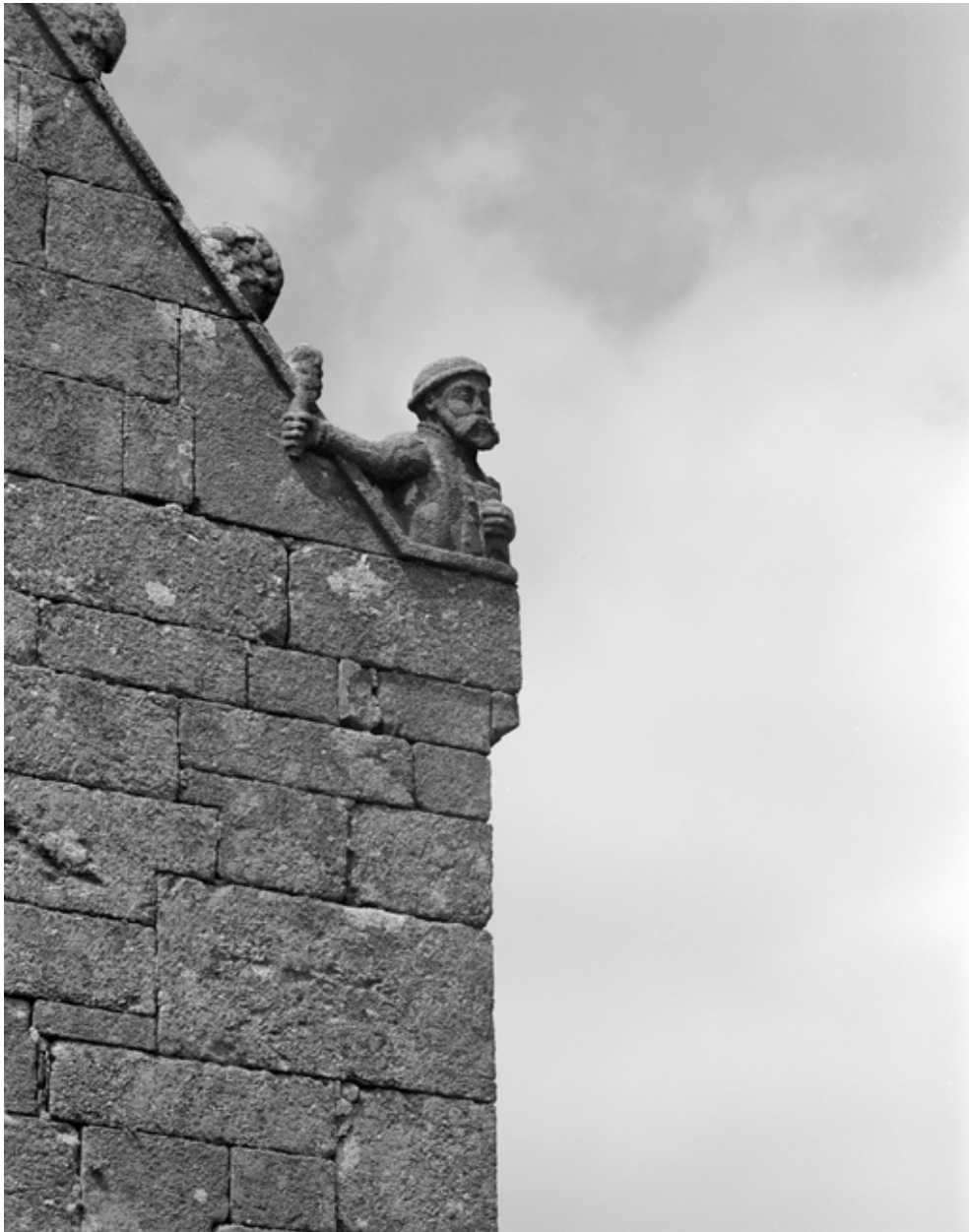
Chevet : détail des crosettes de rampants nord et sud
