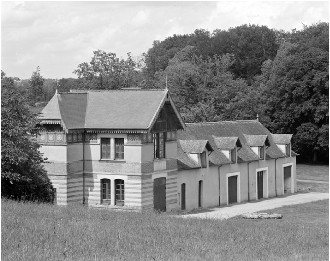
Vue générale des communs.
