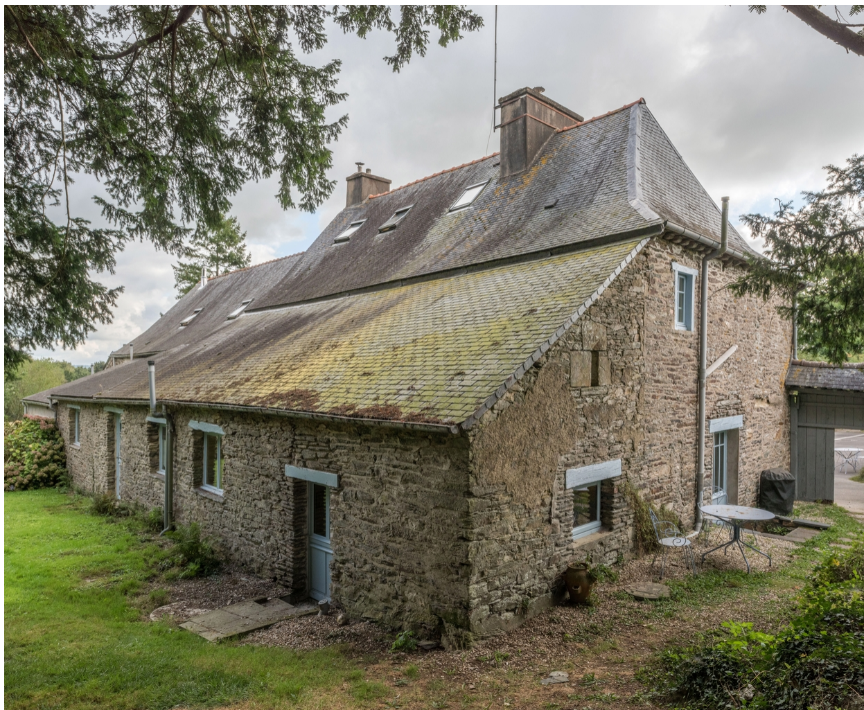
Logis et appentis postérieur, élévation nord-ouest et pignon, vue générale
