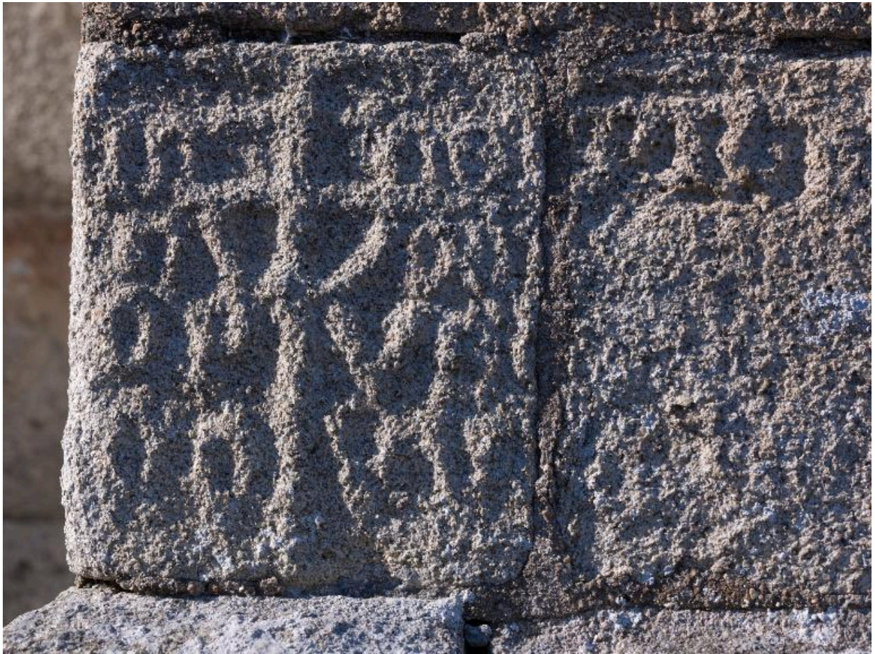
Chapelle sud. Mur sud. Angle ouest. Détail d'une inscription
