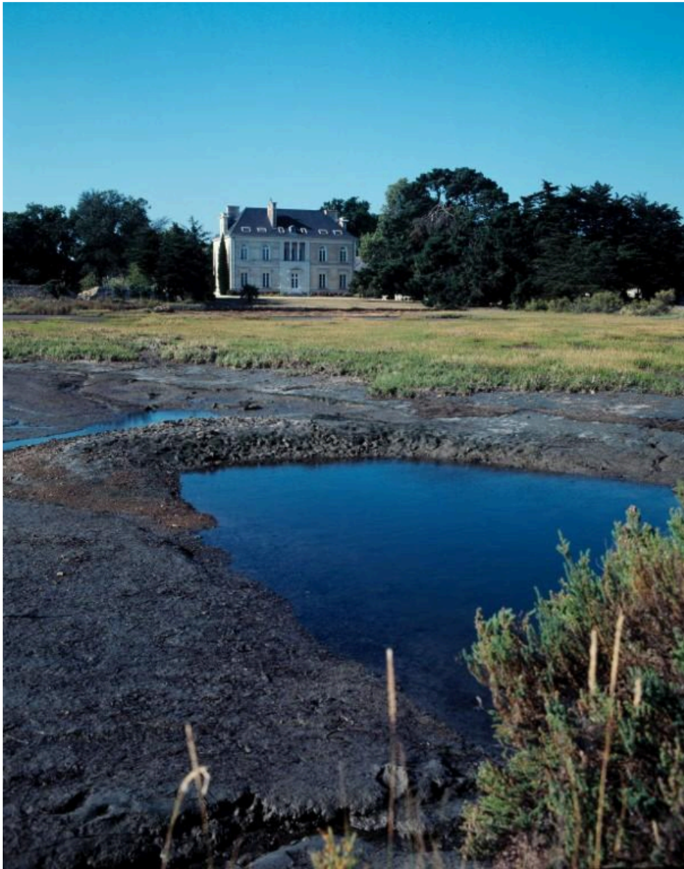
Vue générale nord.
