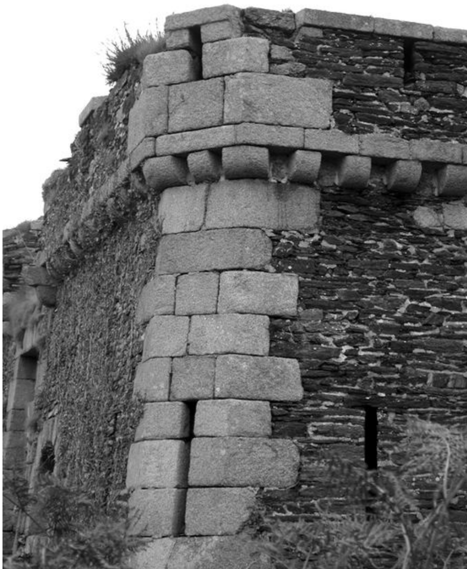
Roscanvel, pointe de Cornouaille : tour-modèle n° 1, créneaux de fusillade sur les angles tronqués
