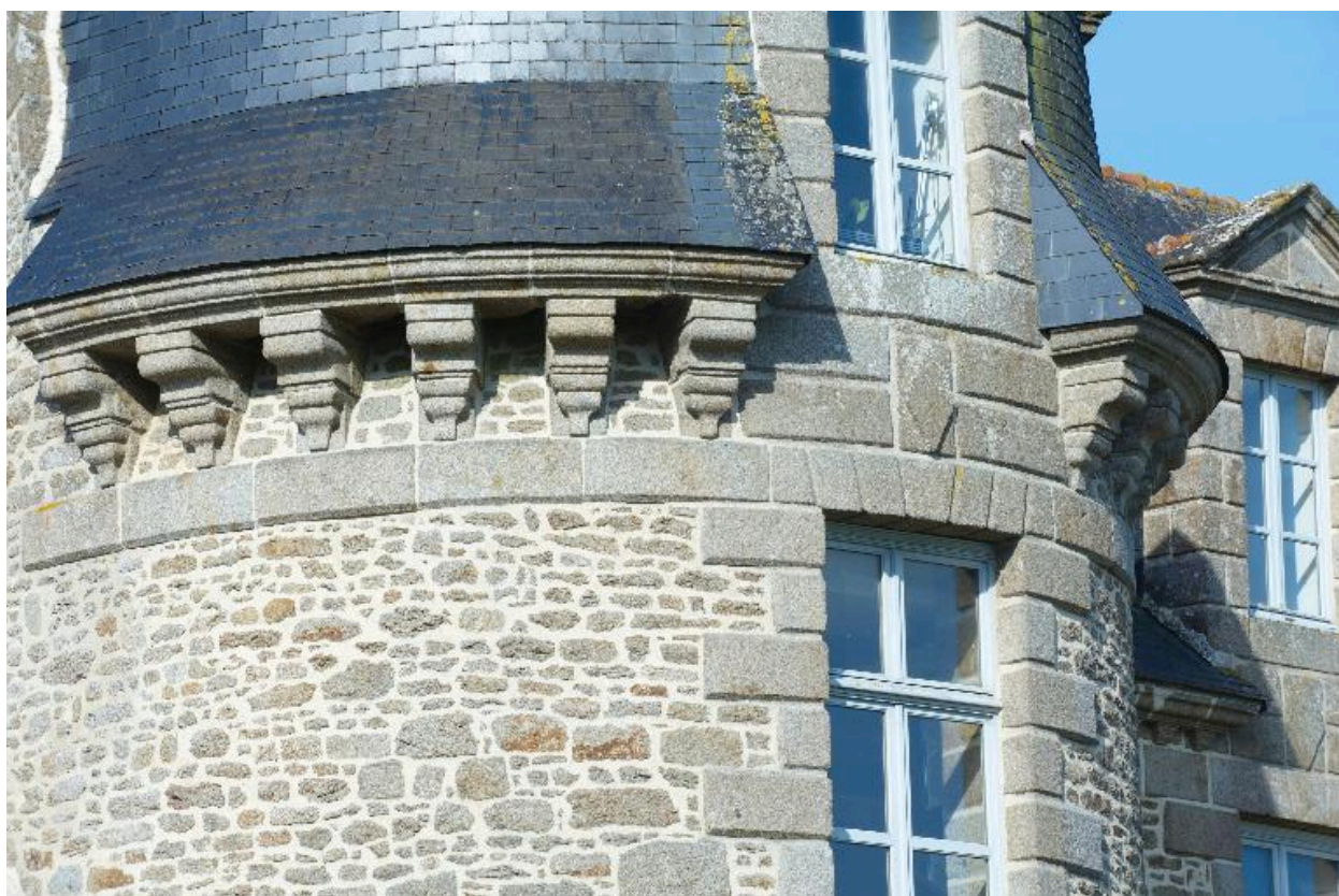
Détail de la corniche de la tour
