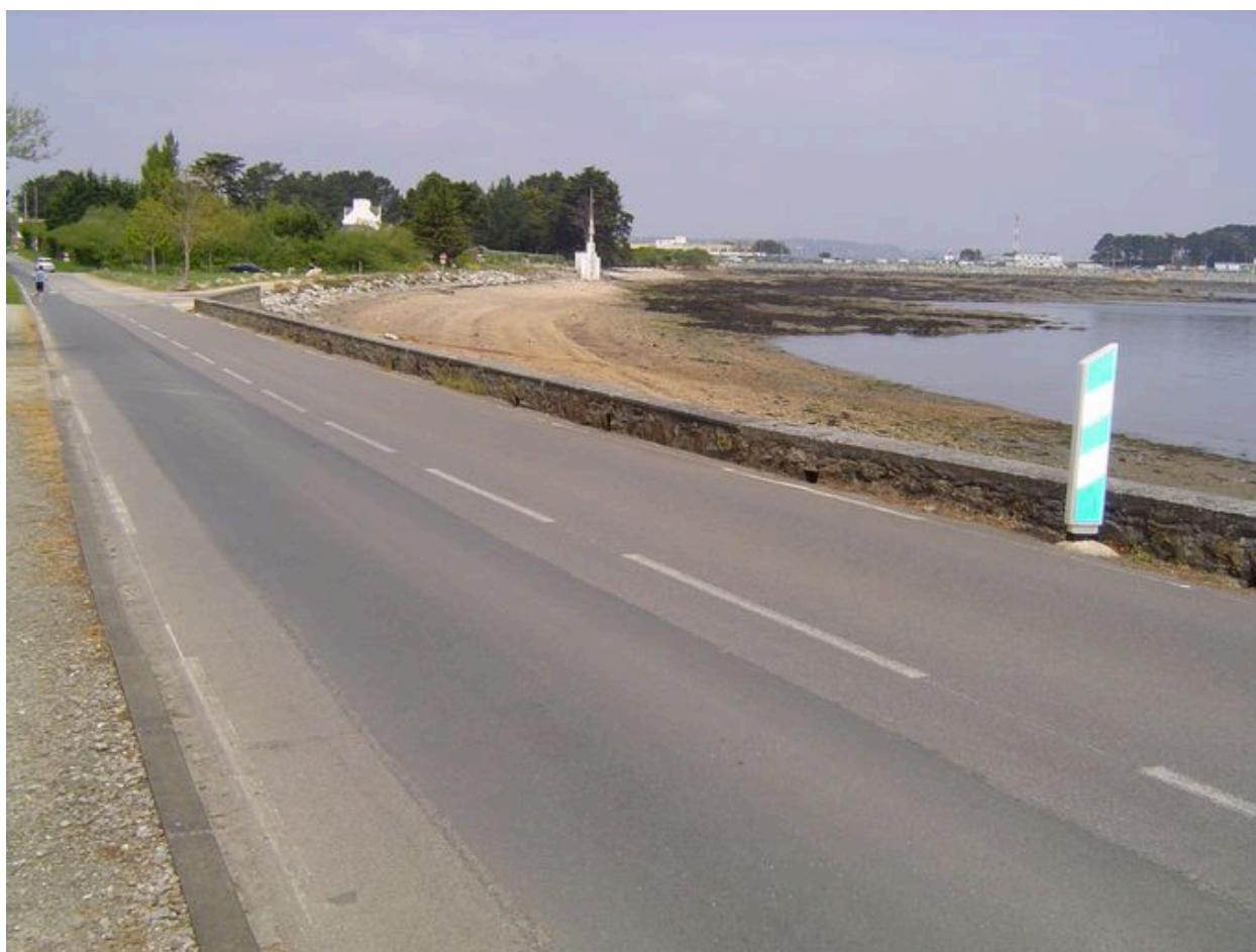
Digue de l'anse de l'Île Longue vue depuis la route
