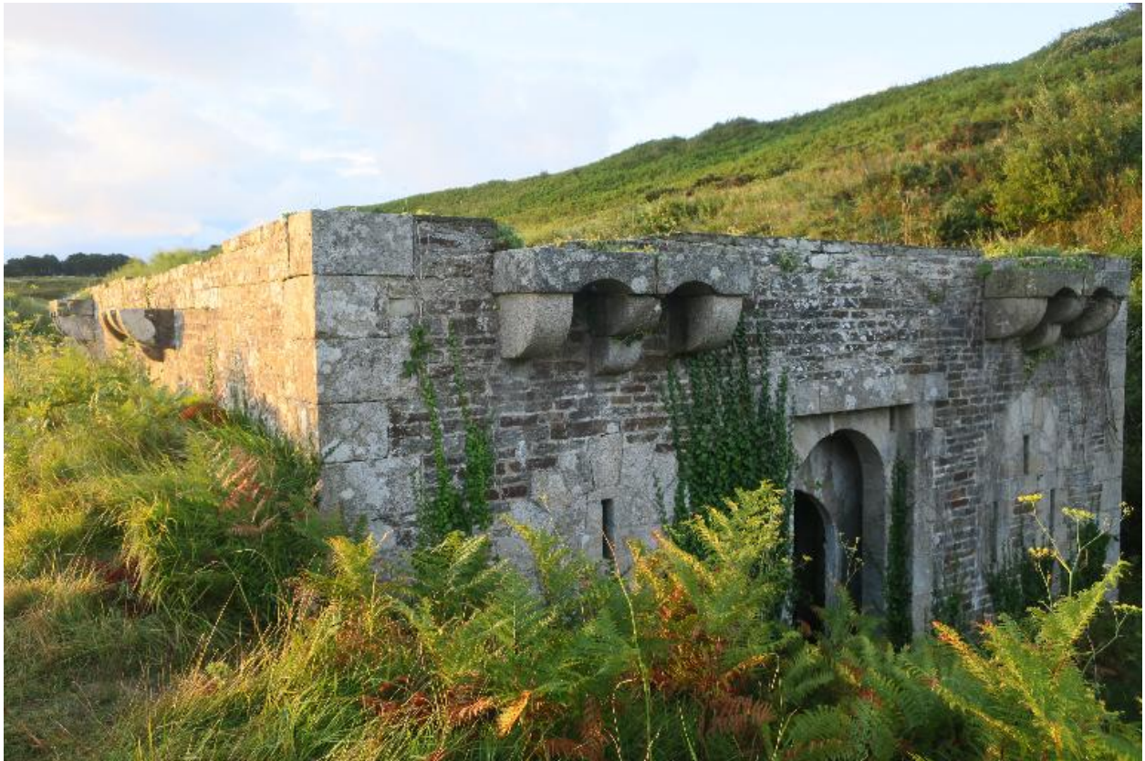
Locmaria, Grands Sables, batterie de La Ferrière, corps de garde crénelé, façade ouest.
