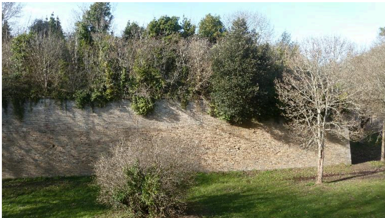
Le Palais, enceinte urbaine, bastion 19, face droite.
