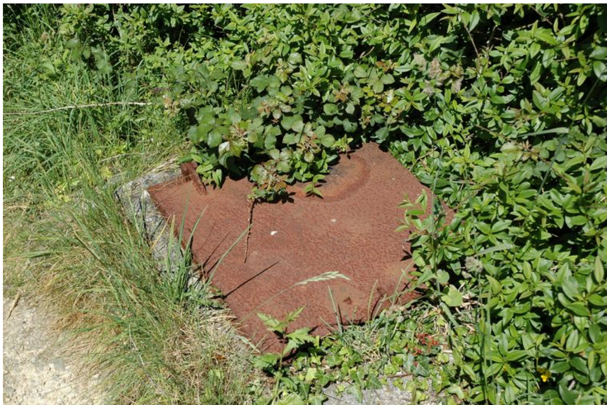
Vue d'une citerne fermée par un volet métallique
